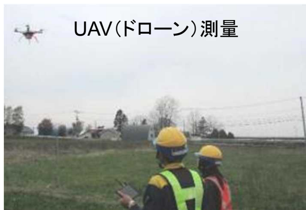
(道央圏連絡道路 泉郷改良工事)
