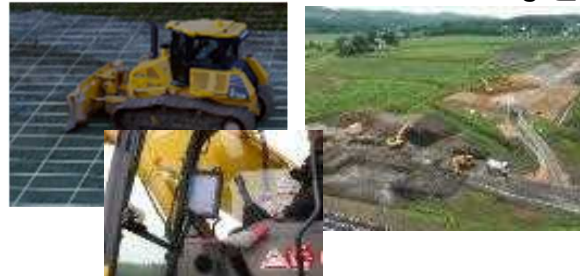
ICT建機での施工
