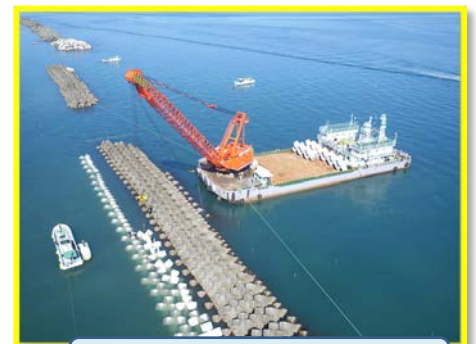
【大型起重機船による本体ブロック据付】
