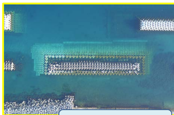
園家離岸堤改良（No108）工事 【平成30年8月4日撮影】
