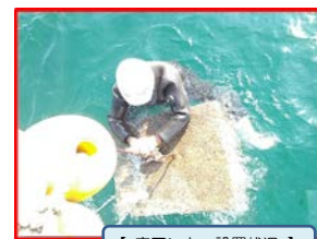
【定アンカー設置状況】
